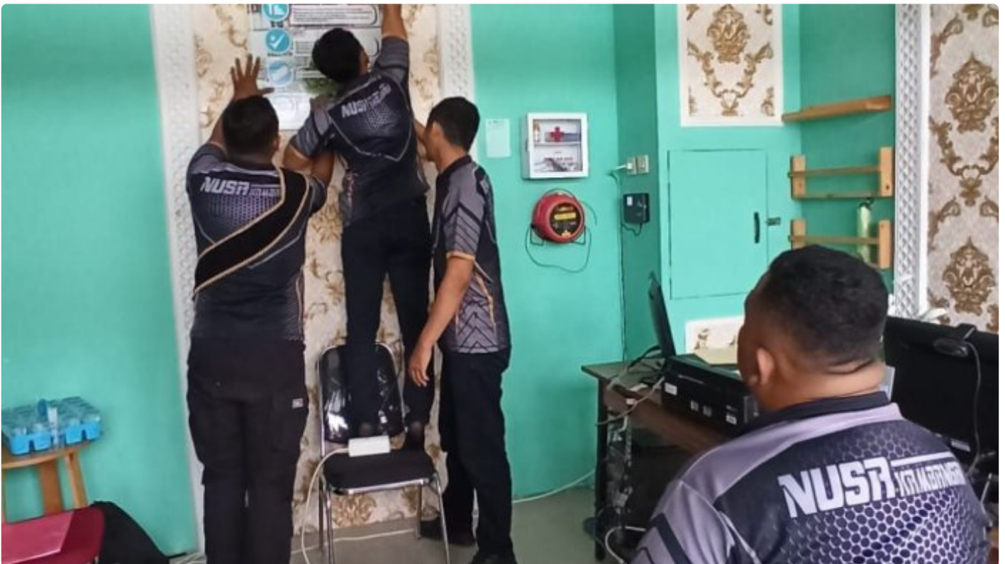
Kabapas dan Staff Renovasi Ruang Baladewa
